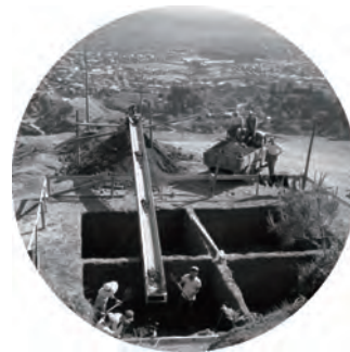
忠霊塔工事の様子
