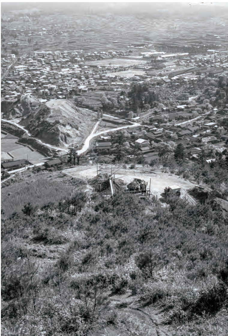
工事中の忠霊塔(昭和34年)
