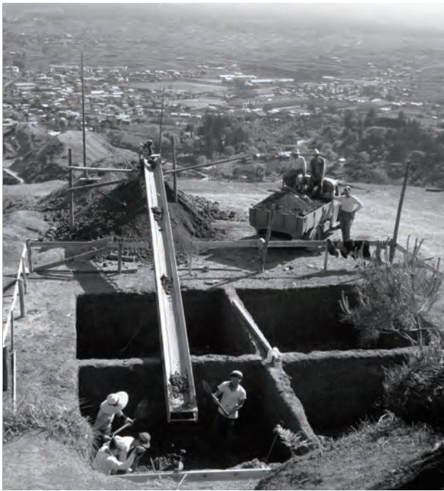
忠霊塔工事の様子（昭和 34 年）
