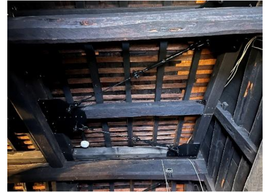
天井裏のブレース
