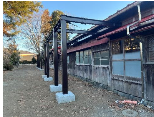
建物外周の鉄骨フレーム
