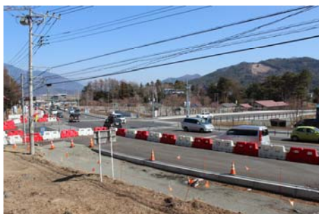
4 車線化工事中の国道 138 号
