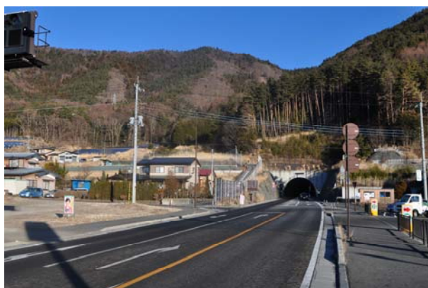
国道 137 号 (新倉河口湖トンネル付近)
