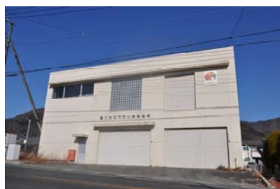
富士吉田市防災備蓄倉庫
