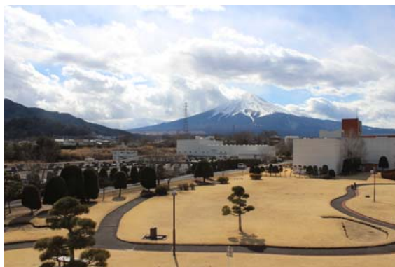
富士北麓浄化センター (下水処理施設)
