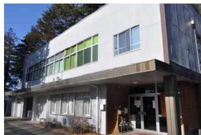
富士山北麓火山防災ステーション
