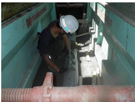
写真：下水道の新設や耐震化工事
