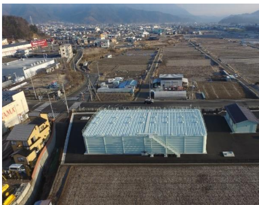
写真：水道施設の更新工事
