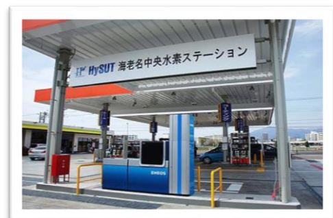
水素ステーション
