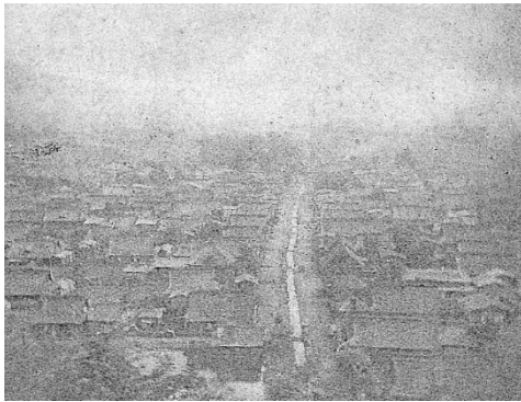
・背戸山から見た大明見（新屋敷）の景観（明治15年）
