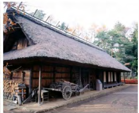
農家(旧武藤家) (市/建 昭和58年8月25日)
