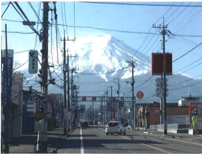
▲整備前 (現況)：電柱、電線、看板類が、美しい富士山の眺望を阻害。昭和通りの現況は、電柱や看板が林立し、架線が道路を横断するなど、富士山の眺望を阻害しています。
