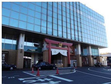
・富士山駅(改修後)
