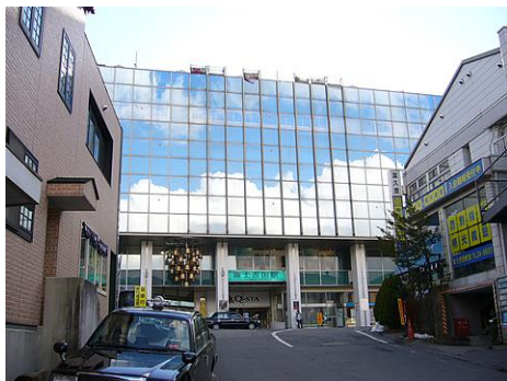
・富士山駅(改修前)
